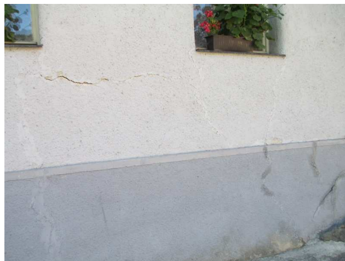
Debnárska ulica, dom č. 30 pohľad od ulice a pohľad zvnútra v miestnosti (stav 7.9.2013)
